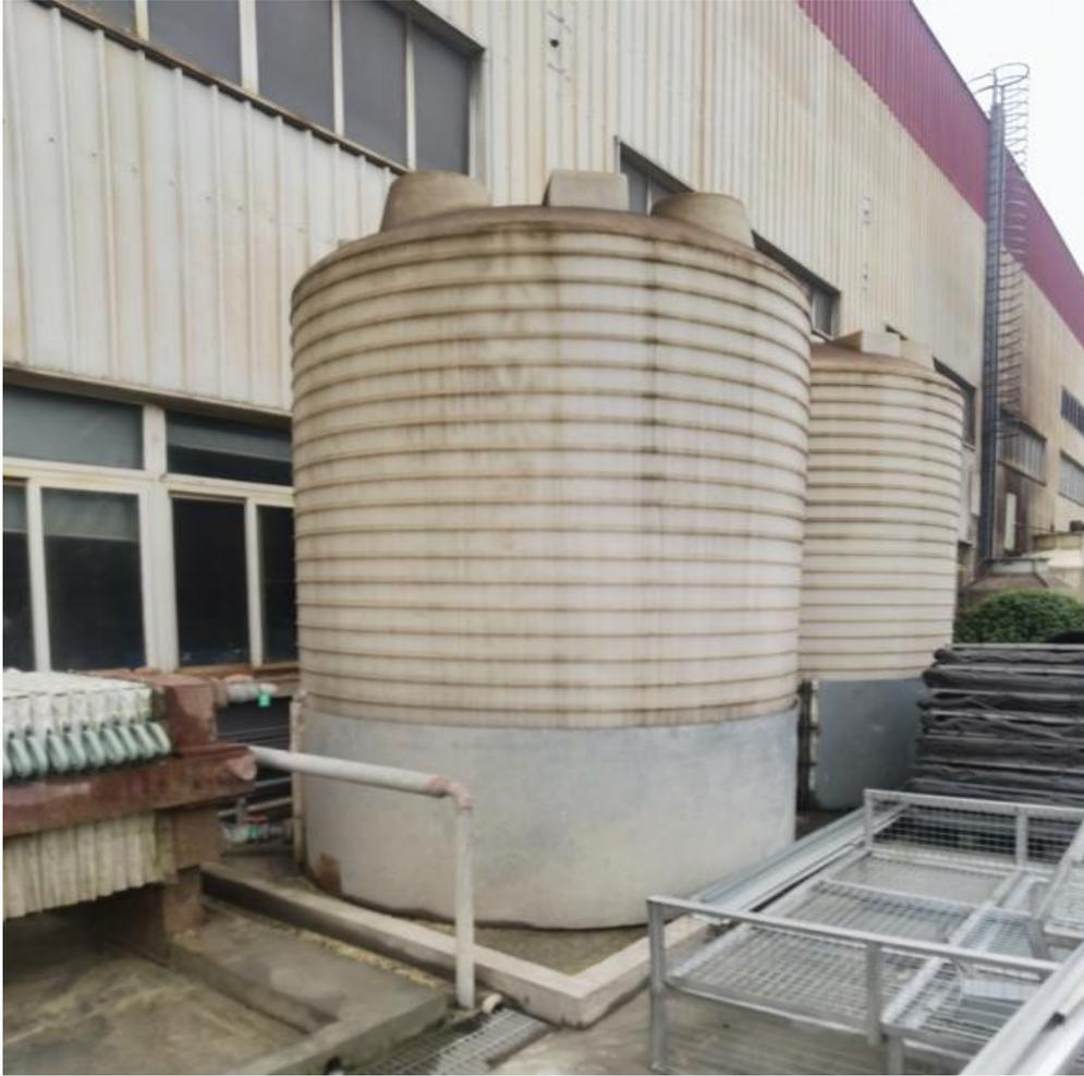
图 3.3-1 磷化线废液储罐
